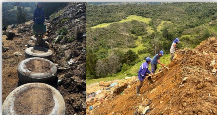
Ilustración 10 Perfilación de talud
