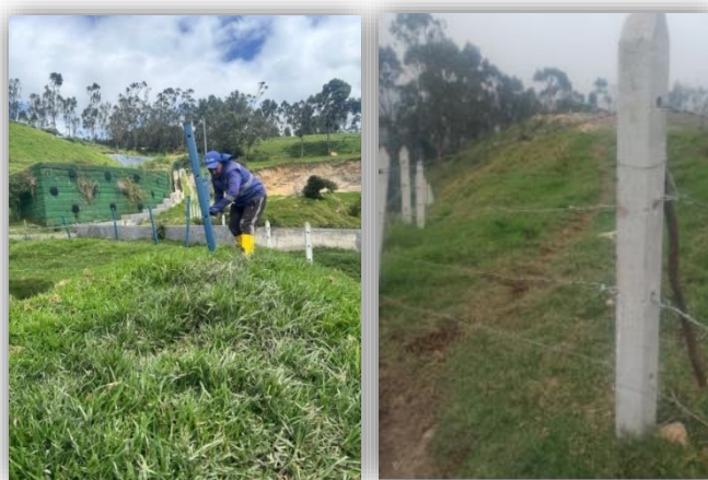
Ilustración 4 Mantenimiento de Cercas Perimetrales
