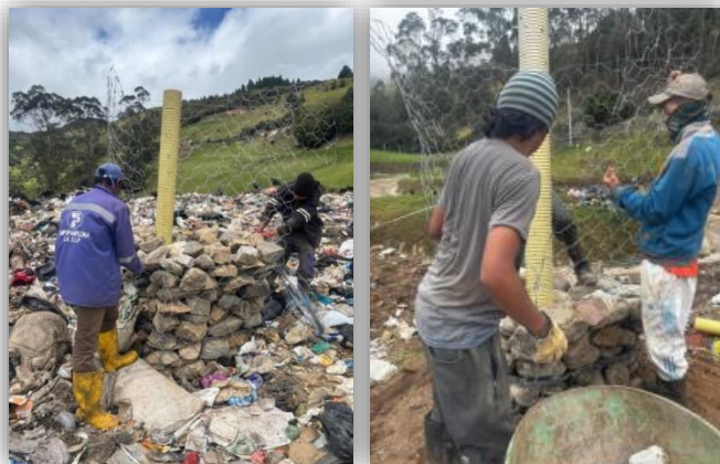
Ilustración 5 Construcción de chimeneas
