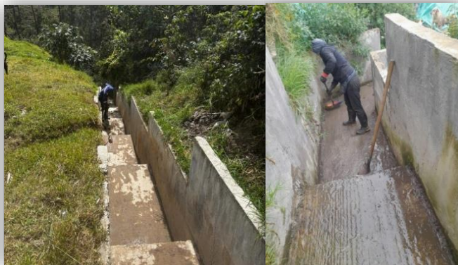
Ilustración 3 Limpieza de Canales Perimetrales de Aguas Lluvias
