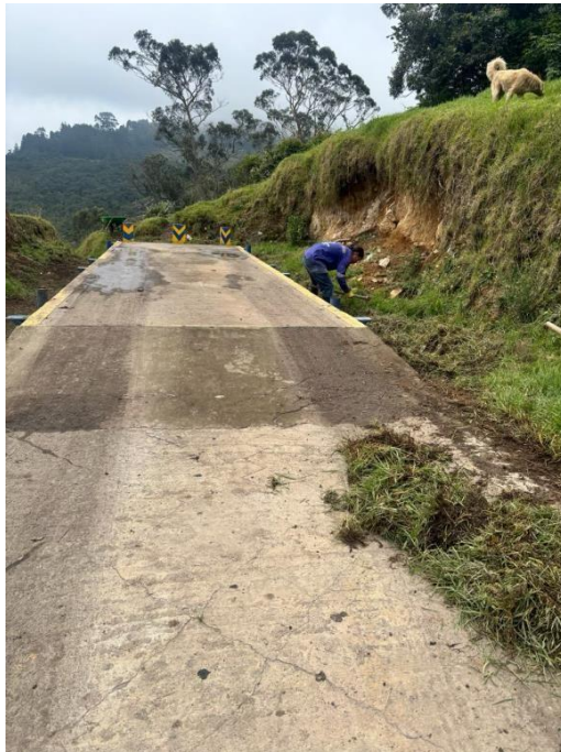
Ilustración 7 Lavado y limpieza de la báscula
