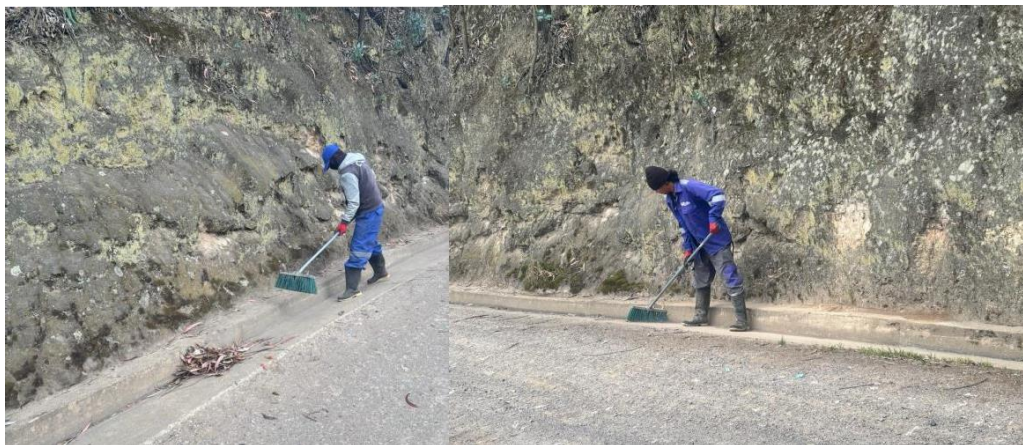
Ilustración 11 limpieza de cunetas
