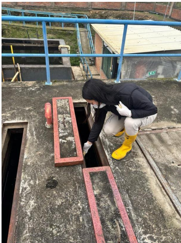
Ilustración 12 Tratamiento de lixiviados
