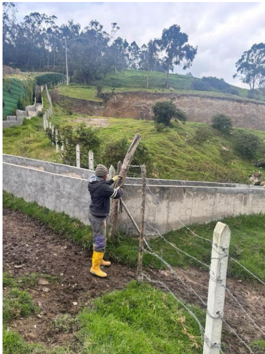
Ilustración 4 Mantenimiento de Cercas Perimetrales
