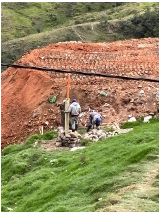
Ilustración 5 Construcción de chimeneas
