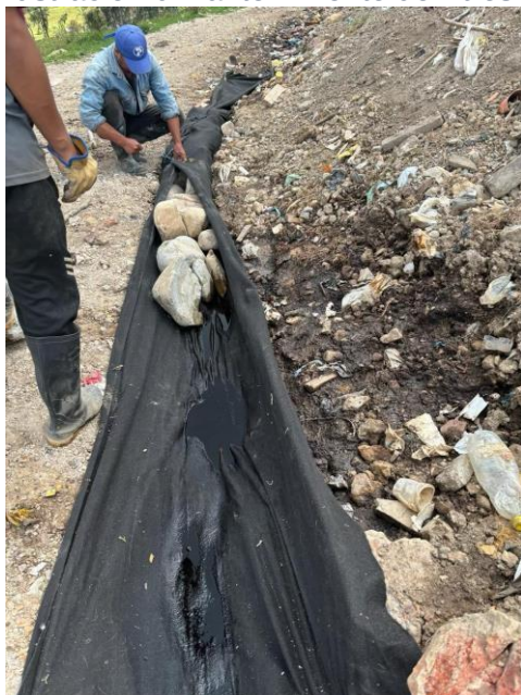
Ilustración 6 mantenimiento de filtros
