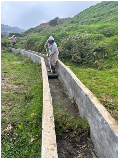
Ilustración 3 Limpieza de Canales Perimetrales de Aguas Lluvias
