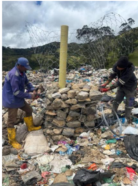
Ilustración 5 Construcción de chimeneas
