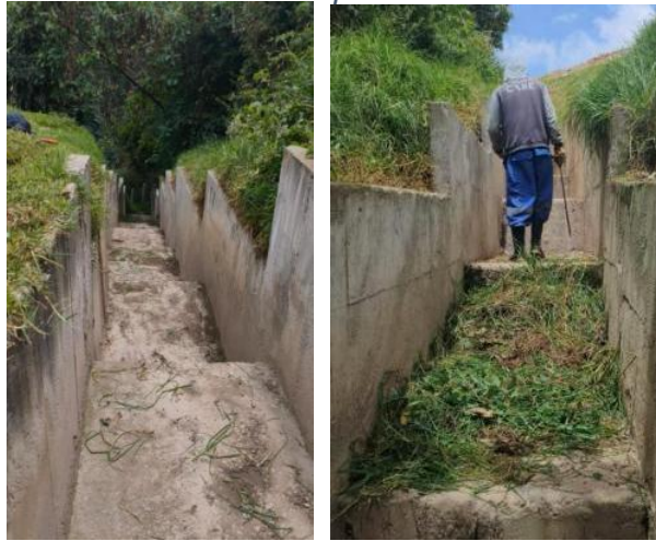
Ilustración 3 Limpieza de Canales Perimetrales de Aguas Lluvias
